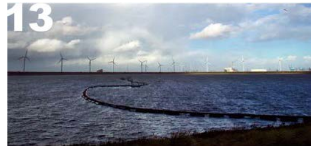
13 MONITOREO, EVALUACIÓN Y AJUSTES Monitoreo continuo de la calidad del medio ambiente
