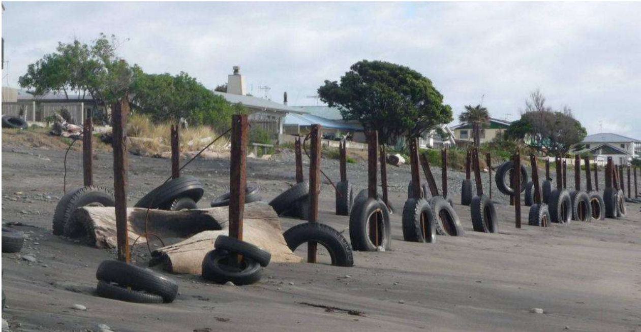
Figura 10 Rieles y neumáticos en Te Awanga. Construidos en los años 1970, continúan siendo valorados y defendidos por la comunidad local como medio económico y efectivo para combatir la erosión.
