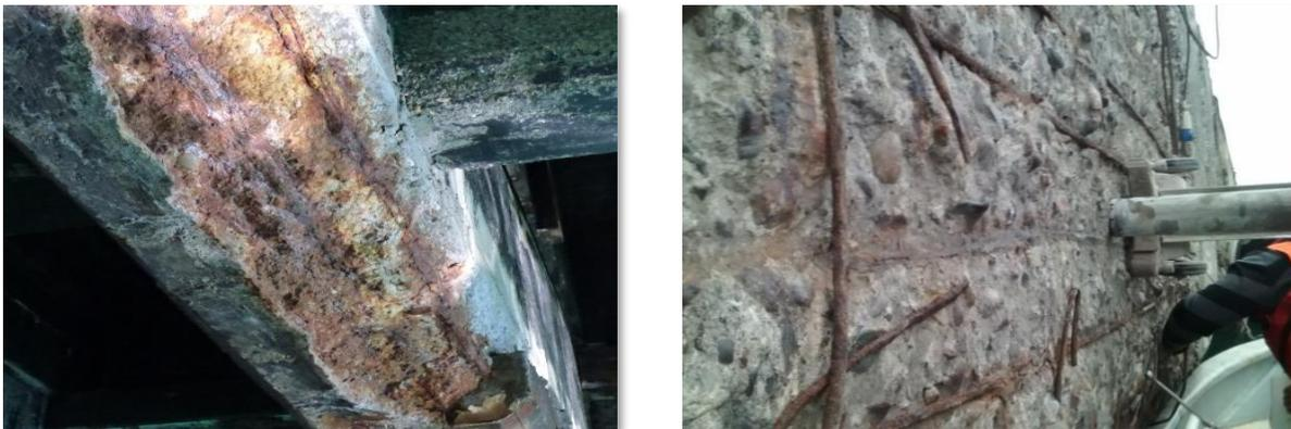
Figura 1: deterioro por efecto de corrosión en estructuras portuarias.
